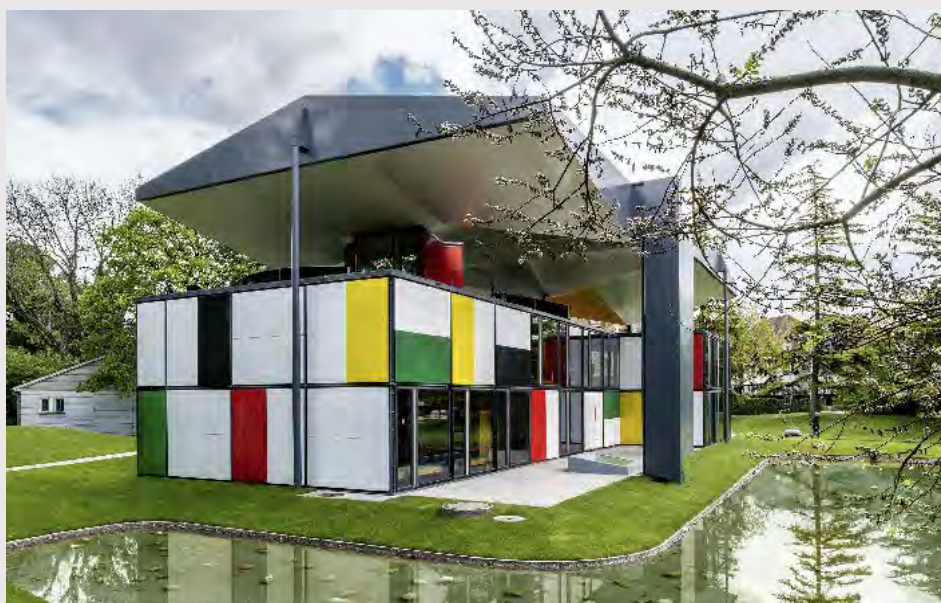
Le pavillon Le Corbusier, Zurich, 1964-1967, inauguré après sa restauration en 2019.
